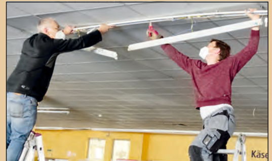
Hermann Hien und Thomas Proll demontieren die alte Beleuchtung
